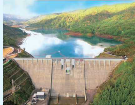
津軽ダム(西目屋村)
