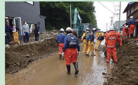
大雨で流れ込んだ土砂の片付けに追われる建設業者ら (2021年8月20日 風間浦村)
