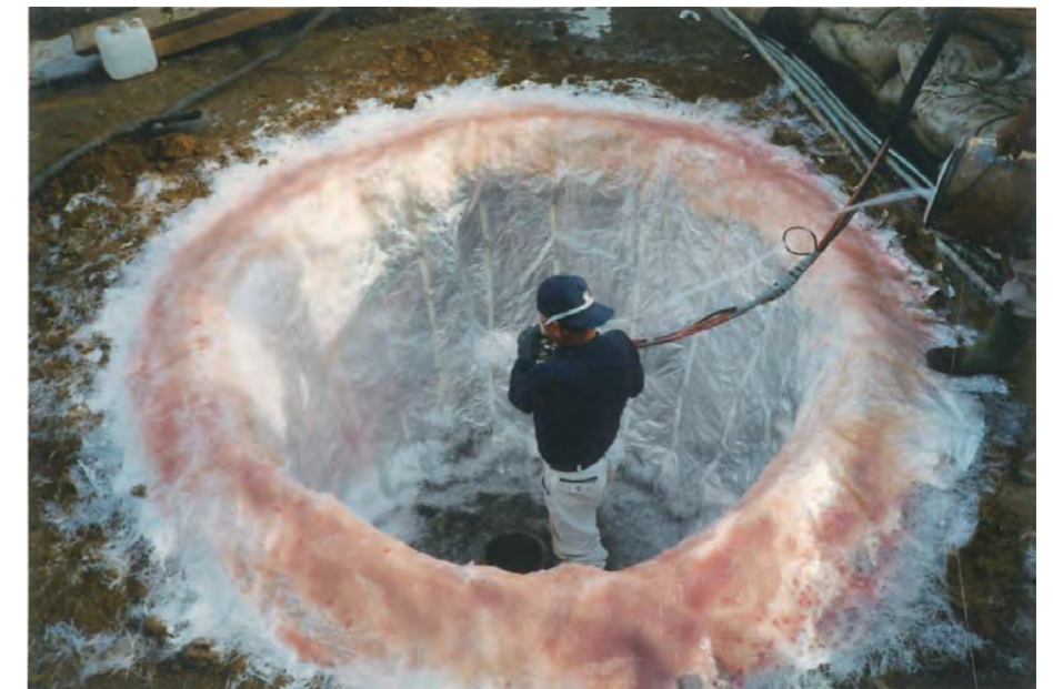
遺構壁面に養生した後にガラス繊維吹きつけ（現状はこの上に擬土貼り付け）
