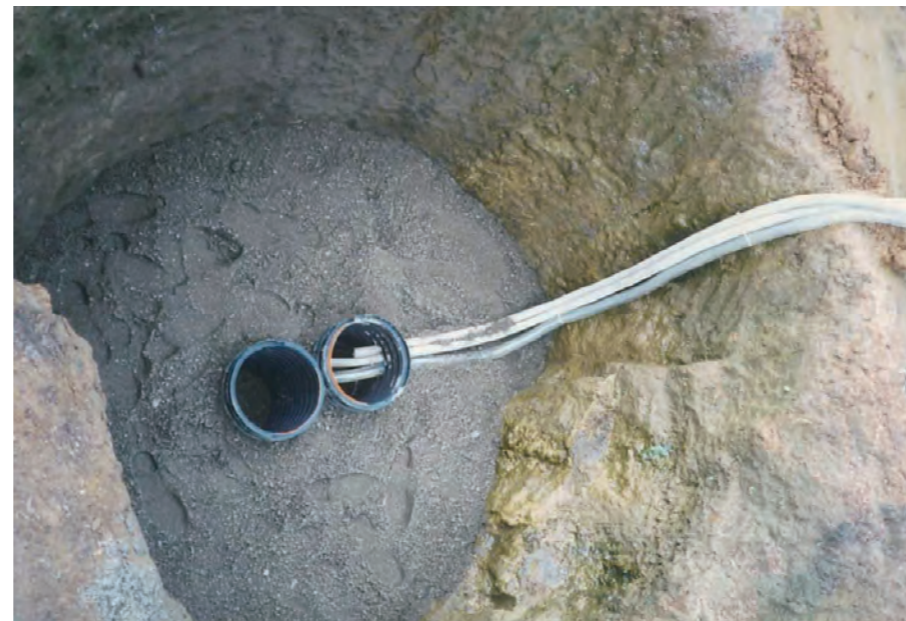
柱穴底面の保護状況（水中ポンプを仕込んである）
