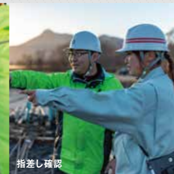
鉄筋が等間隔で配置されているか確認
