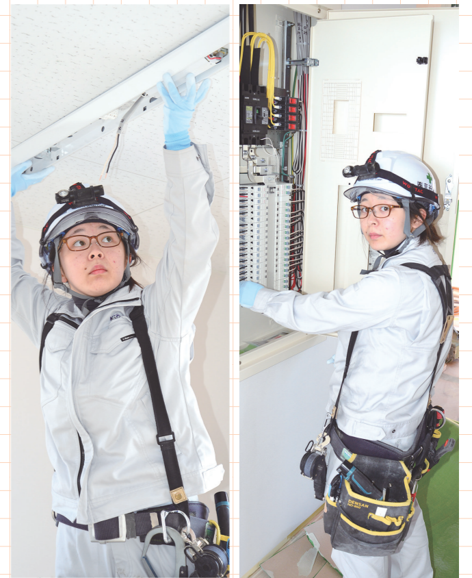
【写真左】小柄ながら、脚立を使って高さ2.7mの天井に照明器具を取り付ける下川さん【同右】分電盤の接続作業もすっかりお手の物
