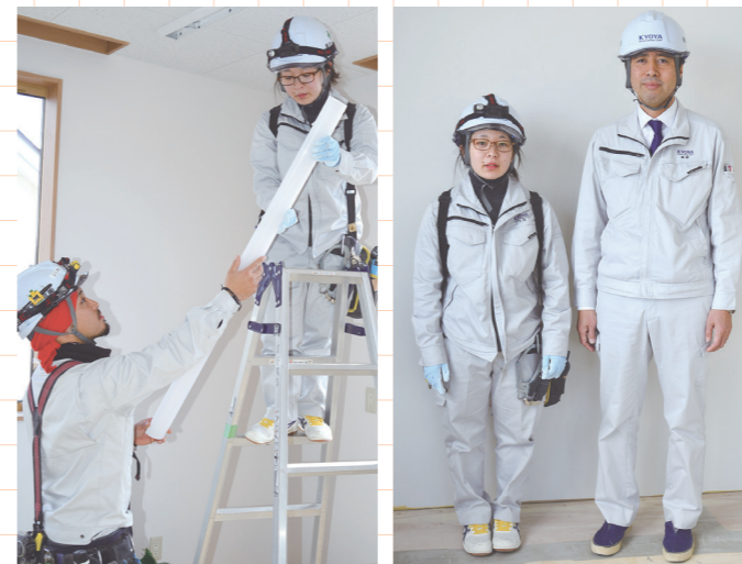
【写真左】先輩工事士の藤田さん(左)に教わりながら、2階の照明器具60台を取り付けた下川さん【同右】高橋社長(右)と下川さん
