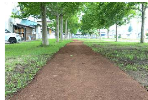
保全地区への施工 [AFTER]
