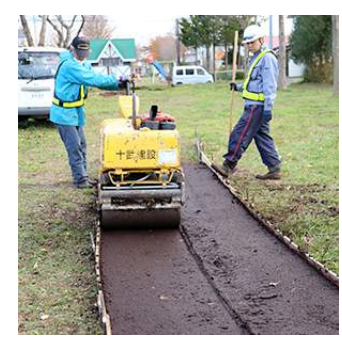
施工中の十和田市保全地区
