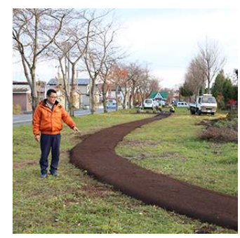
施工中の十和田市保全地区
