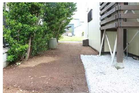
一般住宅への施工 [AFTER]
