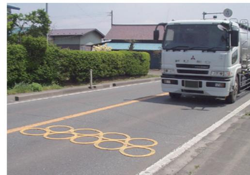
エンジンベルトから着想を得た次世代体感マット『ピタリング』。音と振動でドライバーに注意を促す
