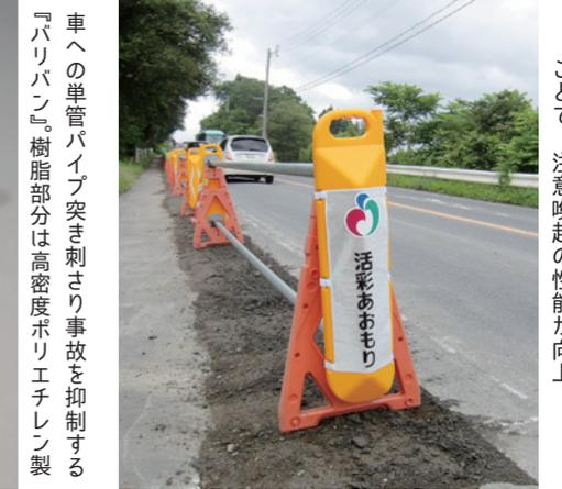
車への単管パイプ突き刺さり事故を抑制する『バリバン』。樹脂部分は高密度ポリエチレン製
